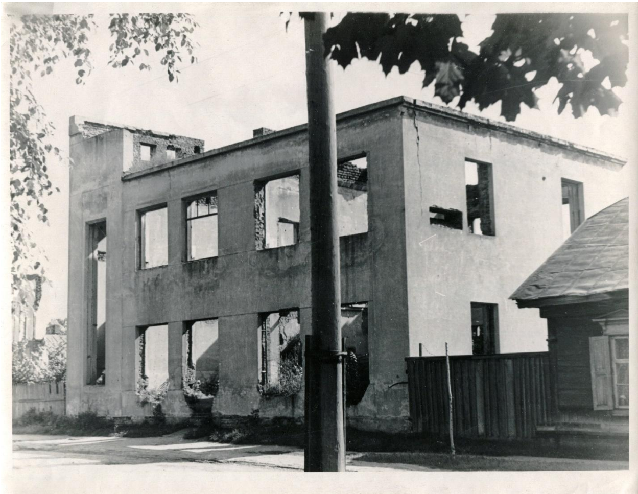
Часть разрушенной коробки здания, в котором располагалось «ГФП», фото после окончания оккупации г. Гомеля.
